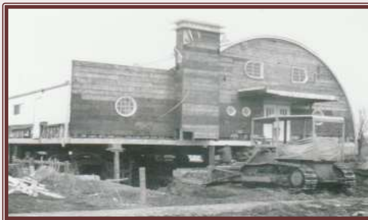
Soulèvement de la salle Raising the hall 1971
