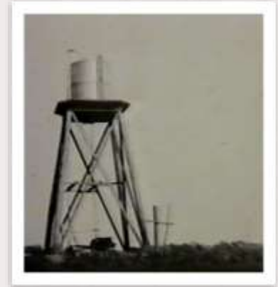
Réservoir d'eau pour le presbytère Water reservoir for the rectory
